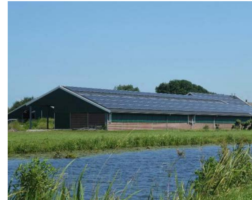
Zon op bedrijfsdaken (Via Duurzaam Nieuwkoop).
